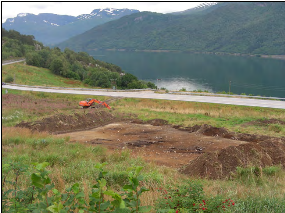
Fig. 153. Lok.6 etter dokumentasjon mot S. Foto H. Handeland.
